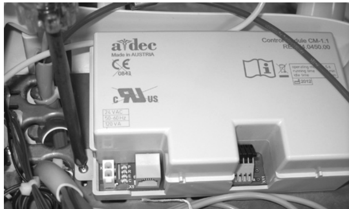
図 28. コントロールモジュールの固定
