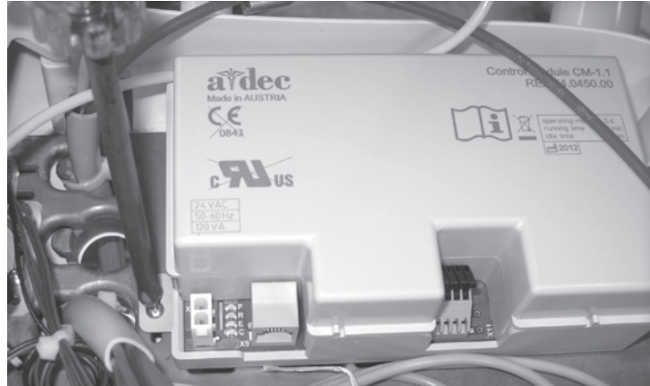
図 11. コントロールモジュールの固定
